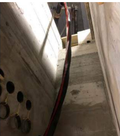
Verlegung in Schächte
