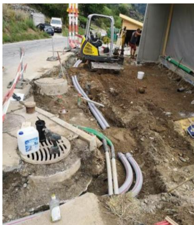
Neue Rohrführungen zur Verteilkabine Glogga
