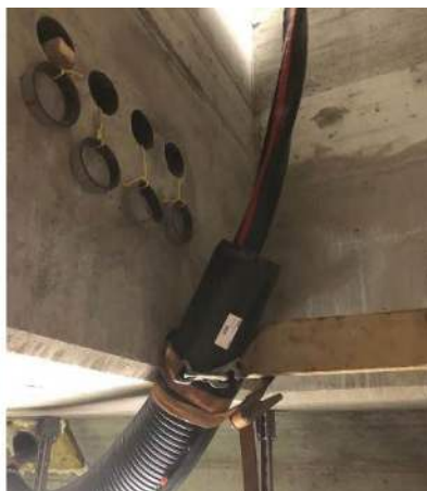
Richtungsänderung im Schacht
