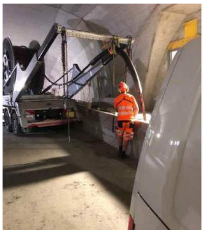
Einsatz Spezialverlegefahrzeug
