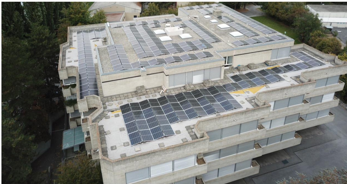
PV-Anlage auf dem Dach des Schulhauses Sand Nord
