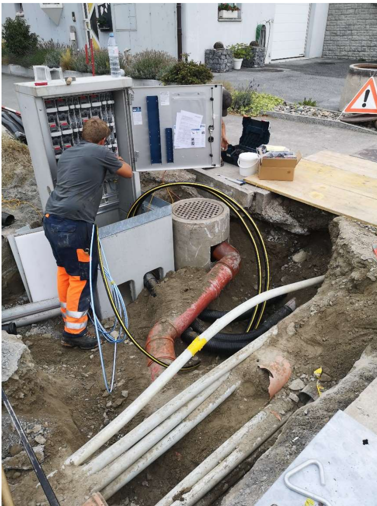
Netzsanierung Schmittenstrasse in Baltschieder
