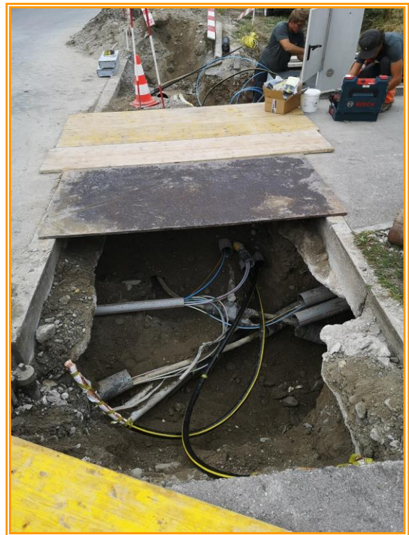
Verlegen NS Kabel inkl. FTTH Speedpipe
