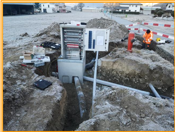
Montage einer Verteilkabine
