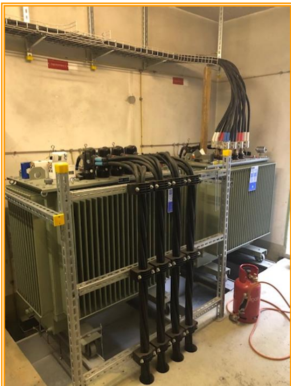
Montage neuer Trafo 1000kVA
