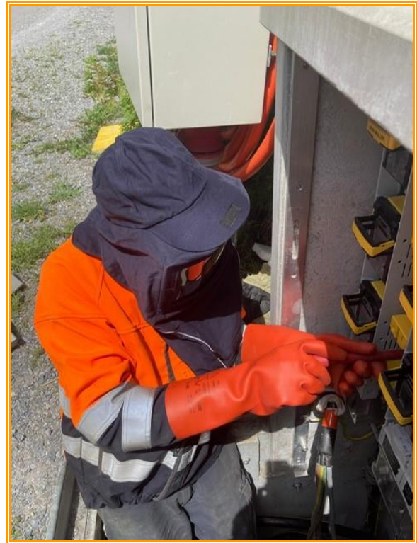
Anschlussarbeiten unter Spannung
