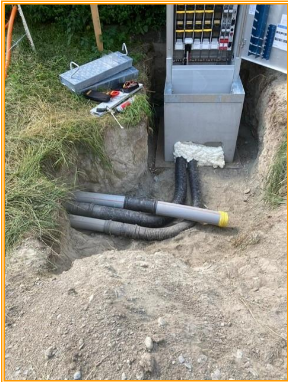
Montage Verteilkabine mit Vorschacht
