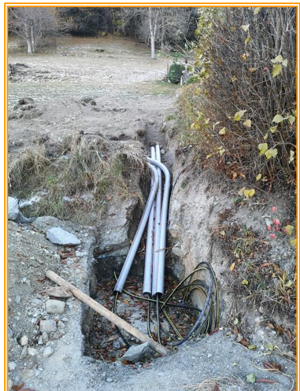
Verlegen NS Kabel
